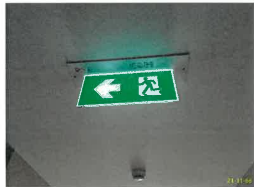
ป้ายบอกทางหนีไฟ (ไฟทางออก) ระบบผจญเพลิงและทางหนีไฟ (ต่อ) ภาพที่ 2.2-9 (ต่อ) ระบบป้องกันอัคคีภัย
