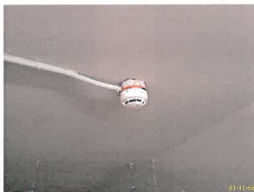
อุปกรณ์ตรวจจับควัน ระบบแจ้งเหตุเพลิงไหม้
