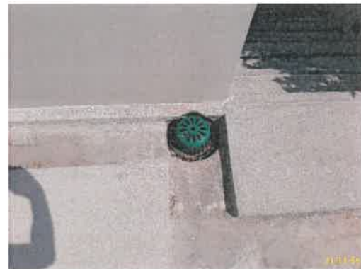
ท่อรับน้ำฝนบนหลังคา
