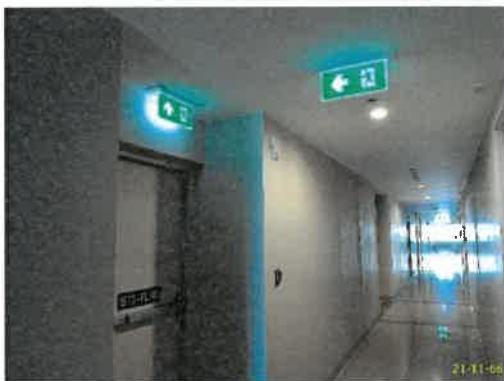
ป้ายบอกทางหนีไฟ (ไฟทางออก) ระบบผจญเพลิงและทางหนีไฟ (ต่อ) ภาพที่ 2.2-9 (ต่อ) ระบบป้องกันอัคคีภัย
